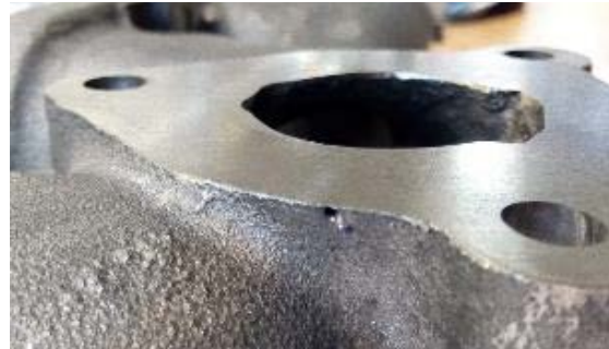
ب. چندراهه دود سوراخکاری شده برای نصب حسگر دما TFM2 شکل ۱۴: چندراهه دود سوراخکاری شده برای نصب حسگرهای دما در اطراف فلنج پرخوران
