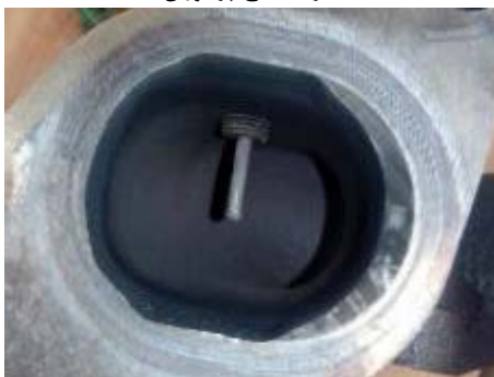
شکل ۱۵: حساسه نصب شده در راهگاه دود چند راهه
